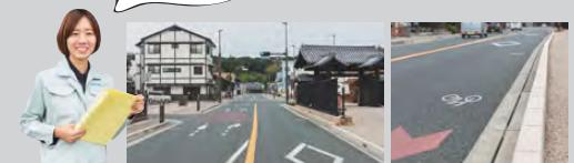
江戸時代の風景を復元するため、歩道は土色、自転車レーンはエンジ色に。電線も地中化して、歩道上に設置する箱形の変圧器が目立たないように配置場所にも気配っています。
