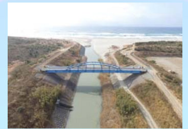
調査箇所：白砂橋（東大谷川）
