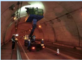
調査箇所：只来トンネル（R362）
