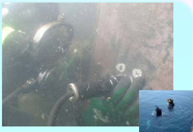
調査箇所：岸壁（田子の浦港）
