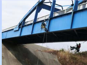
調査箇所：白砂橋（東大谷川）
