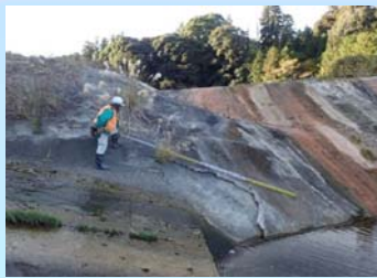
調査箇所：調整池のり面（富士山静岡空港）
